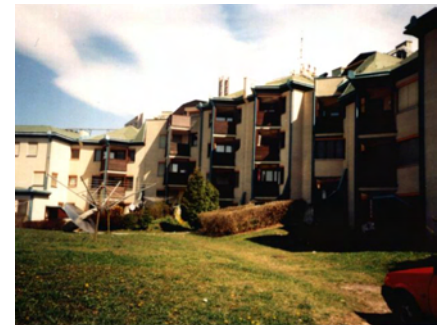
Abb.118 .Algersdorferstraße Block A, Huth
