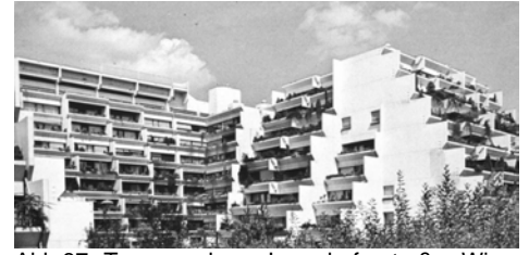
Abb.87. Terrassenhaus Inzersdorferstraße, Wien, Harry Glück, 1968-74
