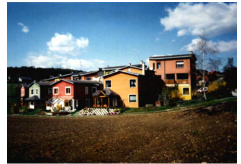
Abb.109. Markt Hartmannsdorf, Windbichler, 1980 Bauzeit 1982-1983
