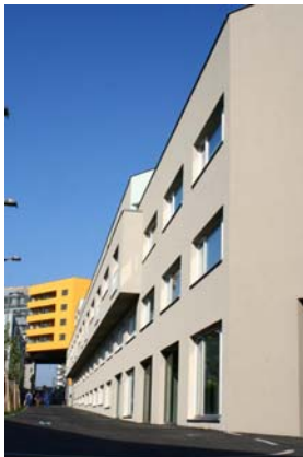
Kabelwerk-Karree und Brückenhaus
